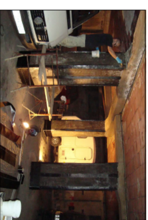
INTERVENTO IN FIBRE DI CARBONIO
