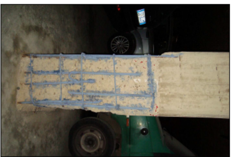
LAVORI DI PREPARAZIONE DEL SUPPORTO
